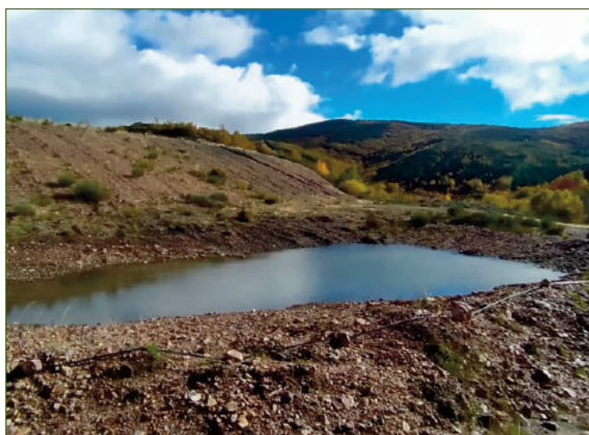
Conseguir que dentro del espacio restaurado exista agua ha sido uno de los objetivos prioritarios. Una de las tres lagunas construidas con el agua ya embalsada.
